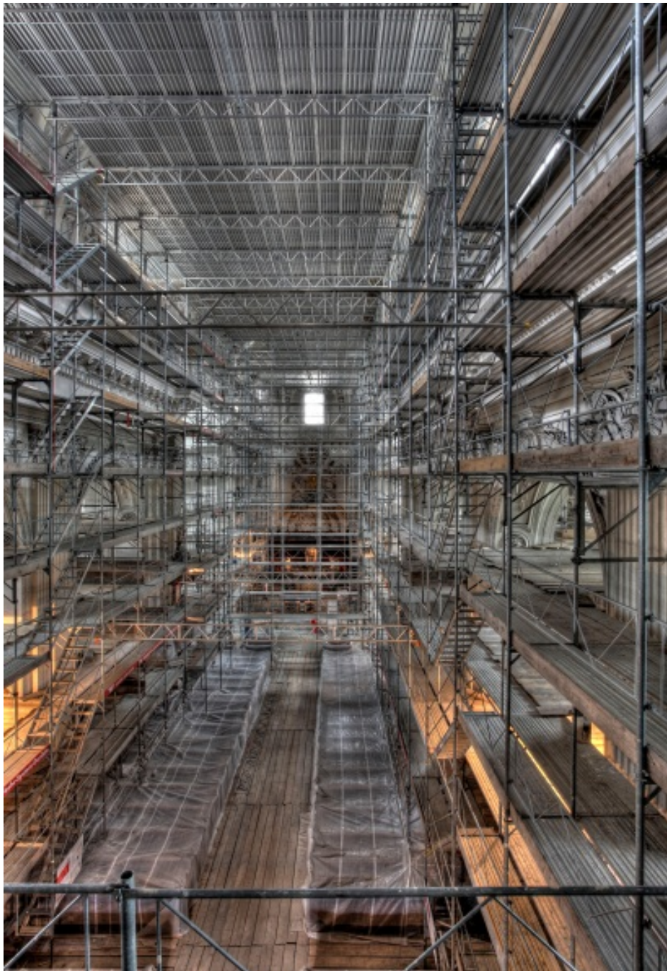
St. Ursenkathedrale mit Baugerüst
